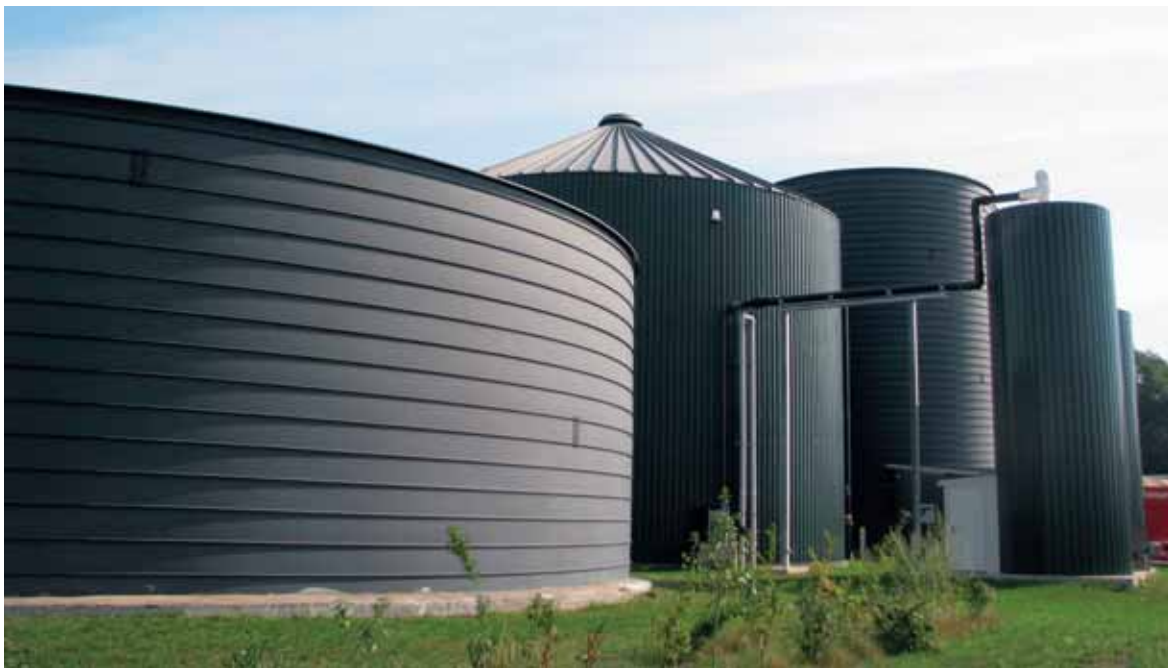
Lokalna ciepłownia na biomase
