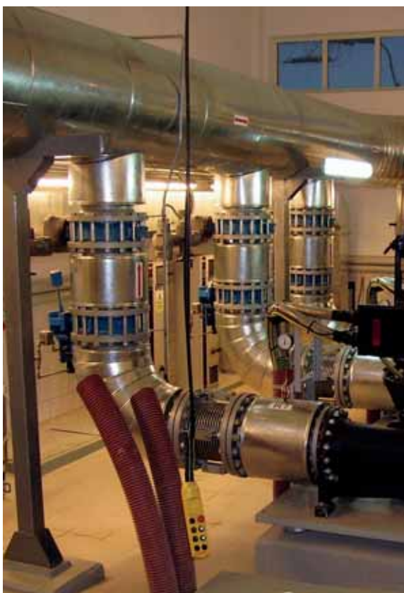
„GPEC Kartuska” realizacja Zakład Innowacyjny Techniki Energetycznych „Promat” Sp. z o.o.
